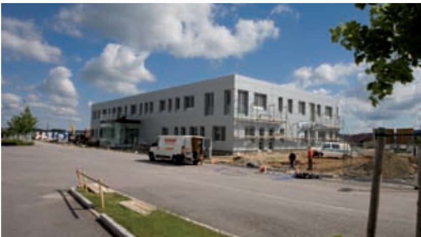
Bild unten: GBO-Forschungslabor vor der Fertigstellung
