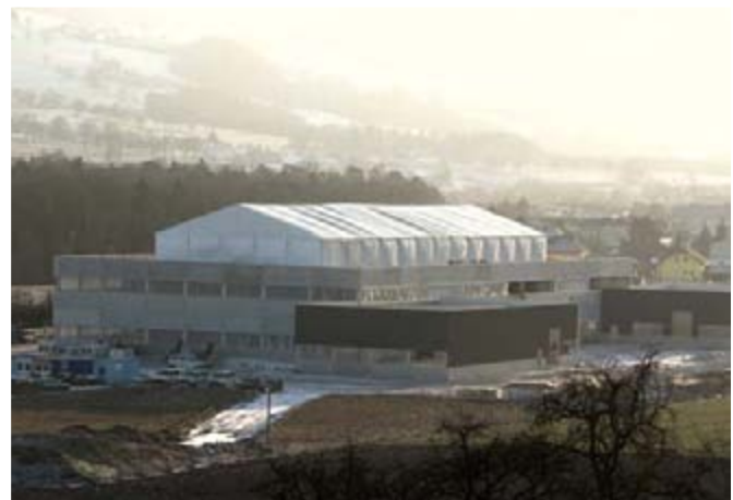
„Bierzelt“ als provisorisches Überdach
